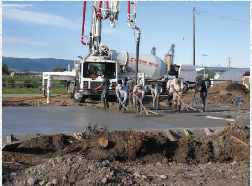
Pouring the mono-slab
